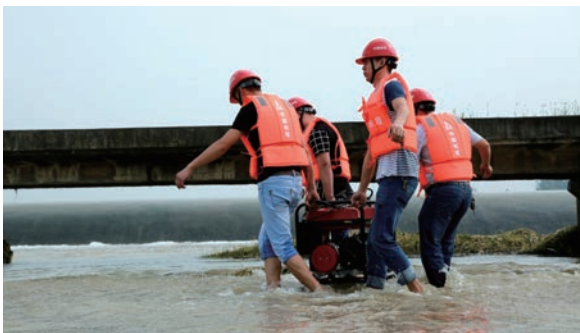
▲ 防汛搶險應急保障現場
