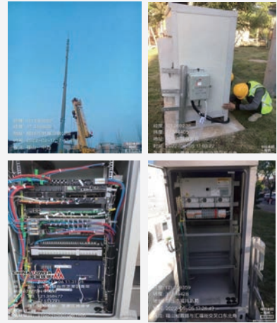
▲ 拆舊物資回收再利用現場
